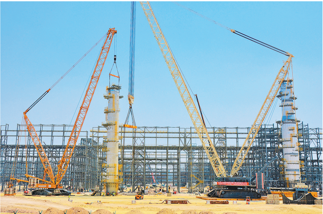
五建公司承建沙特项目完成脱烷塔器吊装
