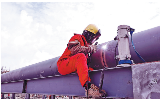
施工人员对LNG储罐配套管架进行焊接作业。李威摄
