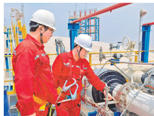
项目团队在罐顶进行管道设备安装质量检查。张渊博摄
