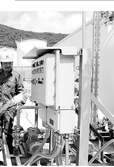
针对当前台风雷暴频发、电力设备易发生晃电风险的情况,安徽石油通过加强电气专业管理、增加安全巡检频次等举措,持续提升抗晃电风险能力,确保生产安全平稳运行。图为8月10日,合肥石油巢湖油库督察人员对装置配电线箱进行隐患排查。
