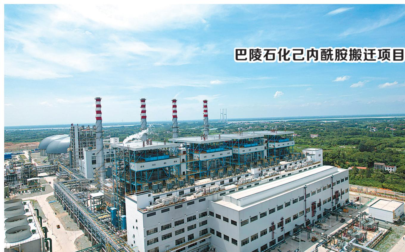
7月21日,巴陵石化年产60万吨己内酰胺产业链搬迁与升级转型发展项目动力站实现中间交接,全面转入生产准备阶段。动力站包括4台480吨/小时高温高压煤粉锅炉、3台50兆瓦汽轮发电机组及相关配套设施。图为动力站现场。
