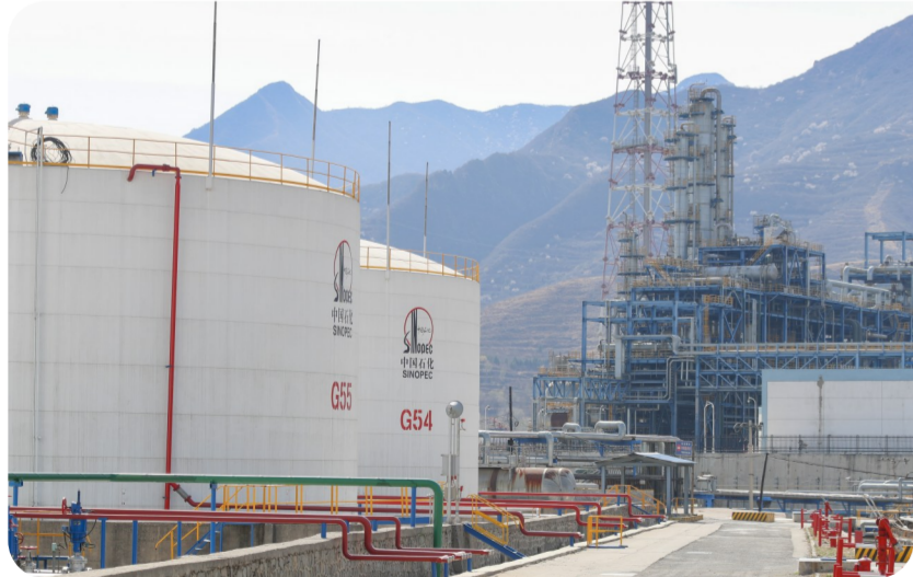
燕山石化清洁高效油品生产基地。
