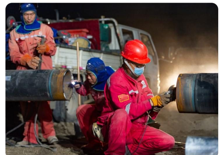
▲3月6日夜间,在临淄区朱台镇施工现场,焊工专注进行对口焊接作业。
