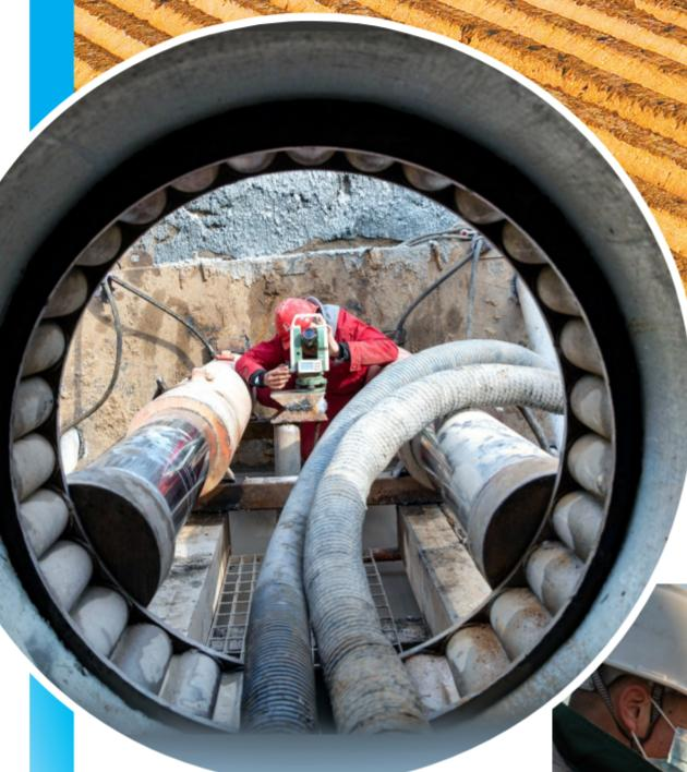
▲2月22日,在克皇公路施工段,工作人员测量机械顶管偏移量,为穿越公路做准备。
