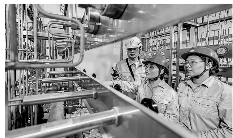
7月11日,扬子石化热电厂锅炉水质在线分析及自动加药项目建成投用。针对热电厂老区锅炉不能实现水质在线连续监测和自动加药调整的问题,他们对锅炉进行改造,提升智能化管控水平。经测算,项目投运后,每年可产生经济效益450万元,降低人工分析成本100万元。图为该厂技术人员查验项目投用情况。本报记者 李树鹏 摄 通讯员 王钦钦 文
