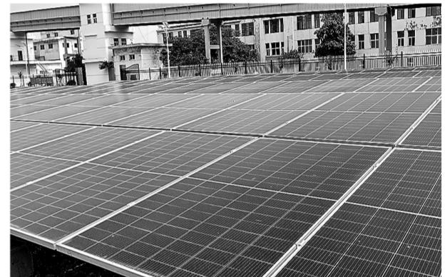
6月初,南化公司首个分布式光伏发电项目并网发电,年发电量可达32.19万千瓦时,大幅减少二氧化碳排放。该项目位于公司厂区内,采用自发自用、余电上网模式,安装524块单晶硅光伏组件,为加氢制甲醇中试装置供电。图为近日项目现场。
