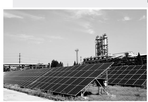
6月中旬,沧州炼化与新星公司合作实施的分布式光伏发电项目并网发电,年可提供绿电98万千瓦时,大幅减少碳排放。该项目自发自用,具有投资少、输配电损耗低、安全环保等特点。图为6月29日项目现场。
