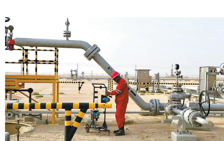
经纬华北测控公司员工在现场检查硫化氢检测仪器。 赵天资 摄
