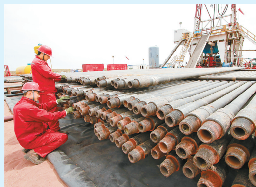
钻杆下面铺设土工膜,杜绝污染物接触地面。
