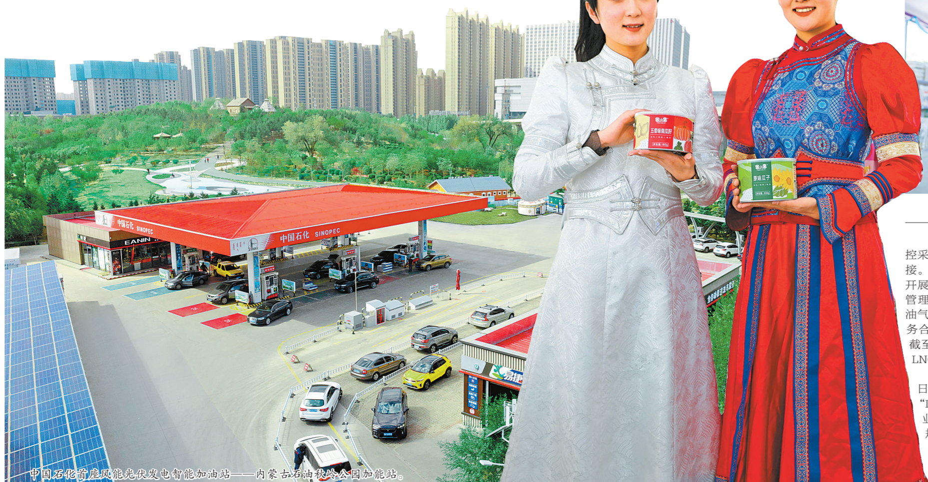
中国石化首座风能光伏发电智能加油站——内蒙古石油穆稔公园加油站。
