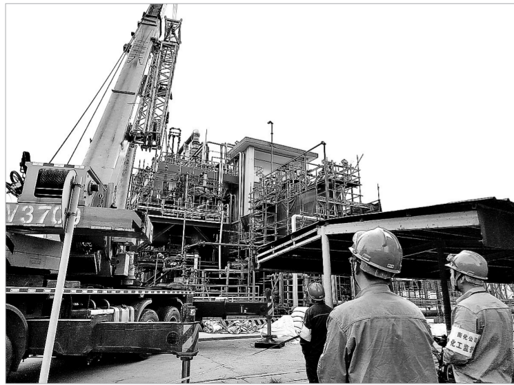
在安全管理强化年行动中,南化公司抓实新版“7+1”制度执行,编制监护人检查卡,加强作业过程中监护人履职检查和考核,严格管控直接作业风险。图为5月17日该公司运行部管理人员检查现场作业监护人员、承包商安全管理现场的施工安全监护情况。
