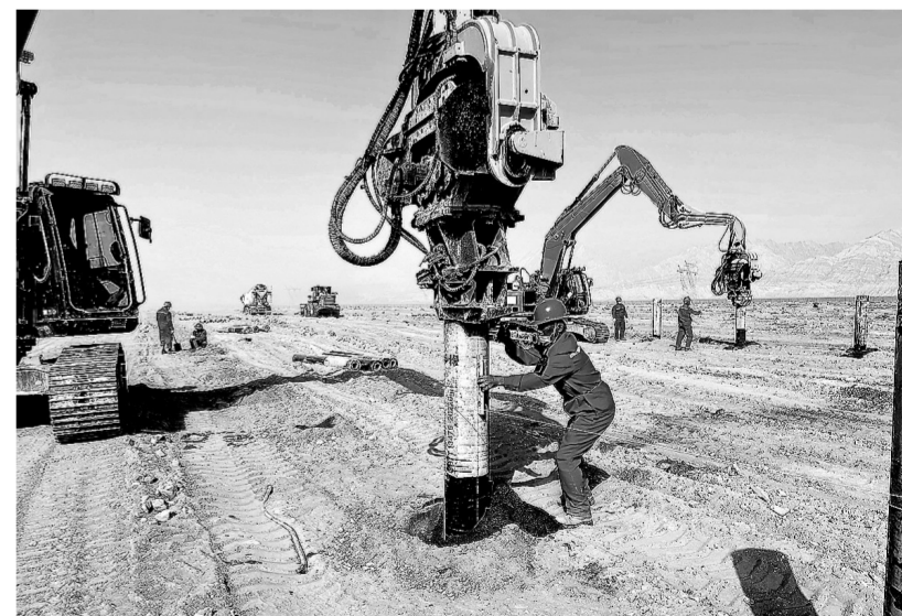
石油工程建设公司中原建工在新疆库车绿氢示范项目光伏发电工程(一)标段项目中,实施教育培训、现场监督、专家指导等措施,实现戈壁光伏桩柱一次合格率由91.1%提高到96.8%。图为施工人员正在植桩。时新鹏 摄 黄俊 赛海健 文
