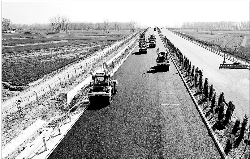
图为近日该公司在连宿高速公路施工,进行主线沥青砼下面层摊铺。 于 鹏 摄
