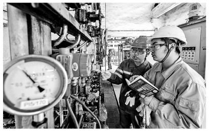
今年以来,扬子石化芳烃厂在设备管理系统中推广使用集数据采集、传 输、分析、预警为一体的动设备智能运稳平台,实时对设备运行状态进行监测, 对异常和故障趋势进行智能诊断和预警,目前全厂动设备监测覆盖率达100%, 大幅降低设备维护成本的同时,降低了一线员工的劳动强度。图为5月初该厂 制苯装置员工现场比对关键动设备运行参数。 李树鹏 摄 裴军文
