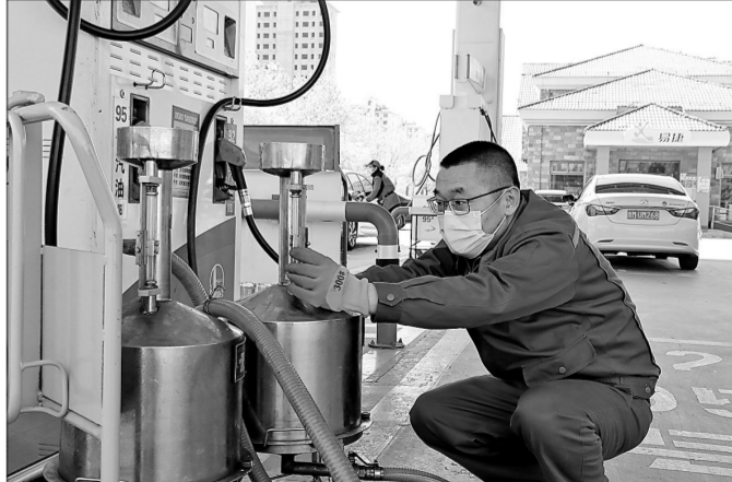
“五一”假期临近,山东滨州石油通过细致检查加油机铅封、对每条加油枪进行精度检测等,进一步强化油品数质量管理,为客户提供优质充足的油品。图为4月18日,公司管理人员进行加油机精度检测。 杨希芹 摄
