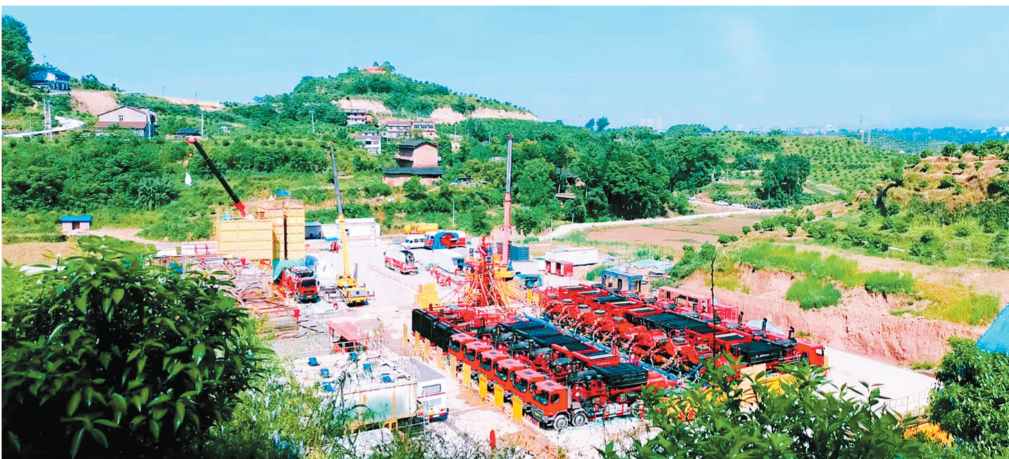
重庆涪陵页岩气田涪陵1井施工现场
