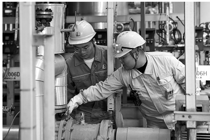
3月以来,扬子石化聚焦降低运行成本,诊断现场低效运行问题,优化乙烯裂解炉运行,攻克EVA装置在线切换难题,减少能耗物耗。图为EVA装置员工在现场查找问题。达军 摄
