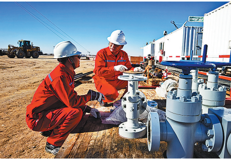
近日,中原石油工程公司科威特公司SP174队开展设备安全大检查活动,该队已连续5年实现安全生产无事故。图为该队员工正在对节流管汇、井控设备进行检查。 张琳琳 尹东杰 魏园军 摄影报道
