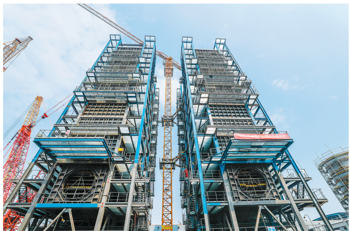
中韩石化在280万吨/年催化项目现场应用智能管理系统,启动防撞预警功能,确保余热锅炉塔吊作业安全施工。
