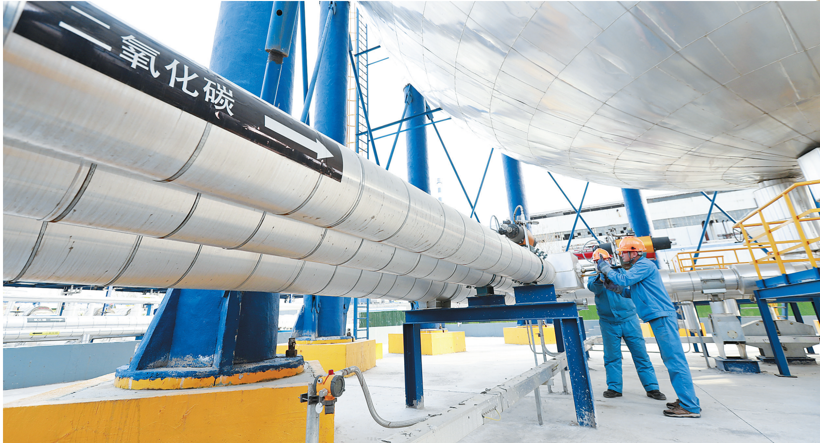
▲齐鲁石化精心维护百万吨级CCUS装置安全稳定高负荷运行,组织好二氧化碳产品装车出厂,实现良好社会效益。图为当班员工细心调整工艺参数,保障装置安全平稳运行。 王敬华 摄
