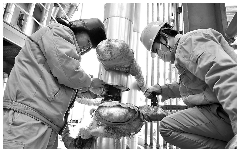
近日气温骤降,石家庄炼化不断优化操作、调整参数,增加巡检频次,严防防冻凝漏项,实现了安全平稳生产。春节期间,企业加工原油11.3万吨,出厂产品11.9万吨。图为常减压装置操作人员在调整生产。
