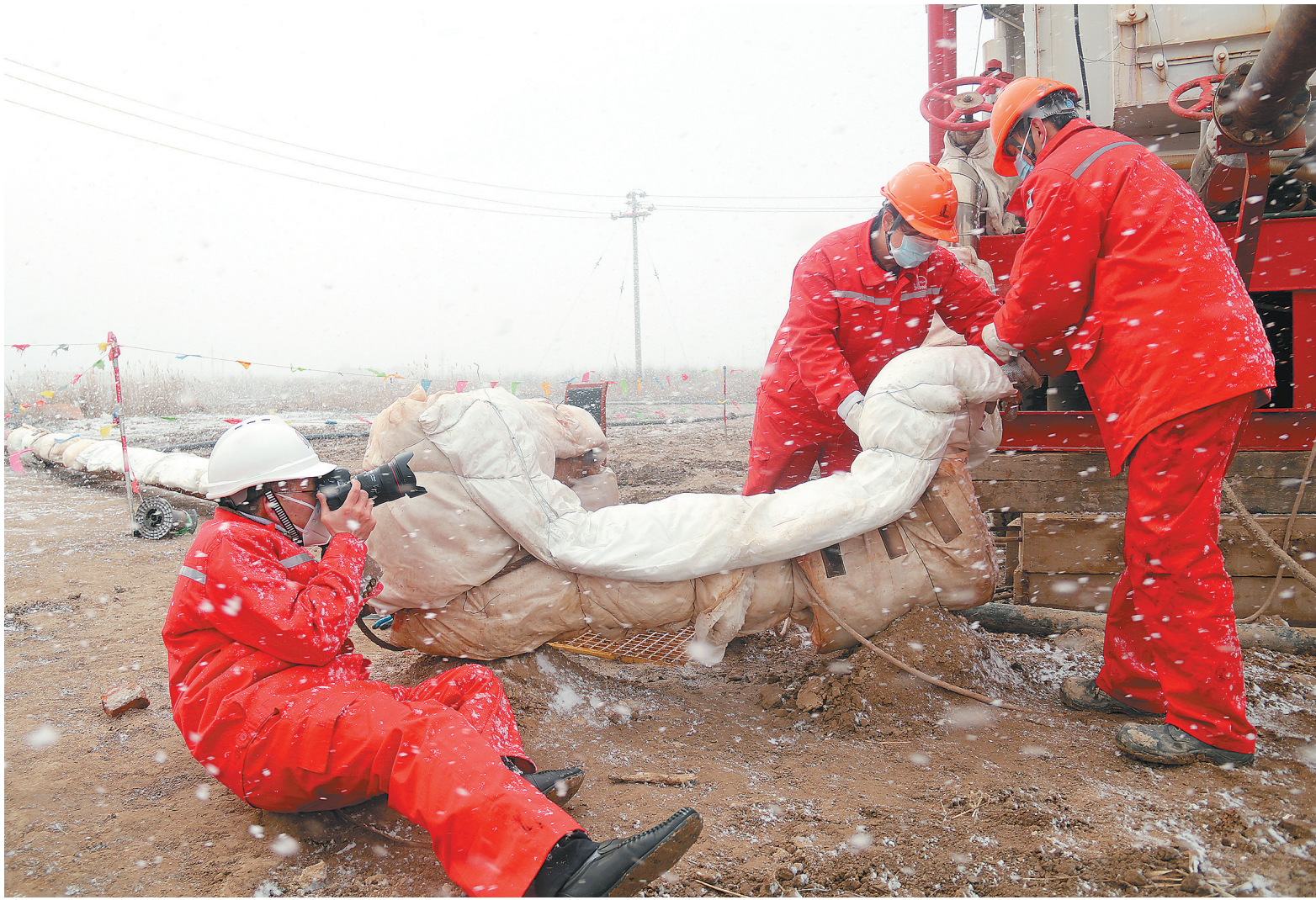
▲1月23日,大年初二,在胜利油田孤岛D24X29注汽现场,胜利油田记者王国章拍摄值班人员加固注汽管网保温棉。 盖振峰 摄
