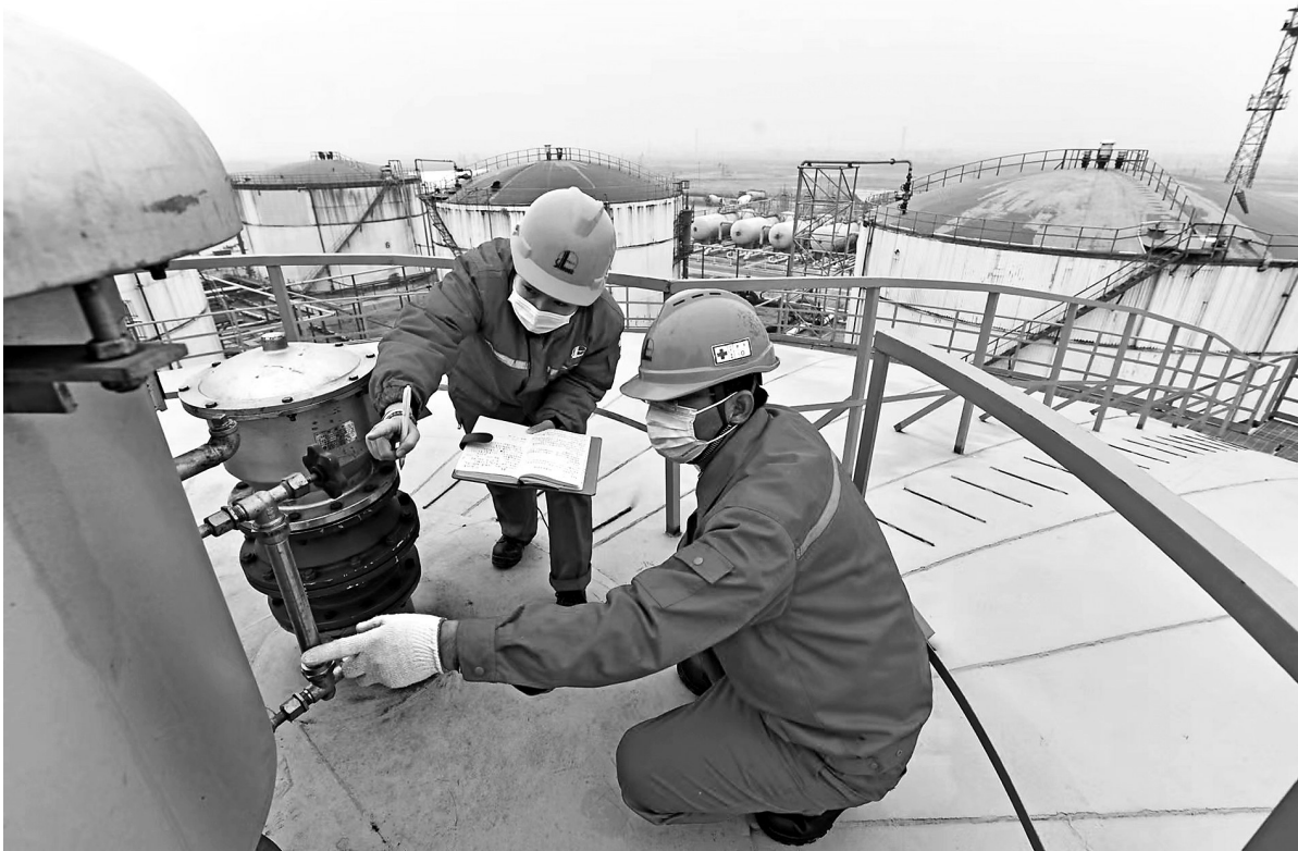
胜利油田河口采油厂扎实开展“百日安全行动”,加大对采油、油气集输系统关键点排查力度,全面识别安全风险,对排查的各类安全隐患及时整改。图为11月9日,该厂油气集输管理中心安全员对原油储存罐安全阀进行排查。 吴木水 摄 甘 冰 文
