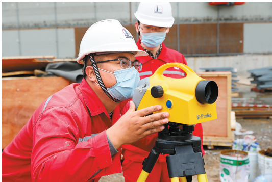
施工人员开展储罐环墙沉降监测工作。
