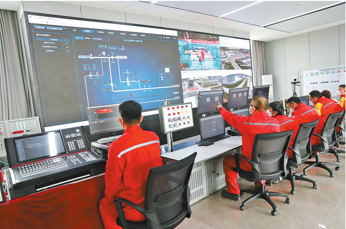
新东营原油库管控中心里,员工远程启动阀门,原油库投产进油。
