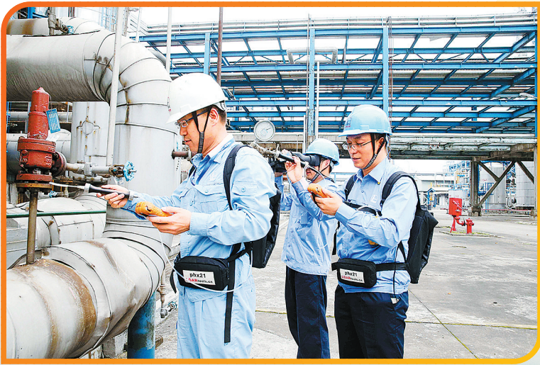
广州石化持续开展无异味工厂建设。图为技术人员在利用LDAR技术对现场密封点进行检测。
