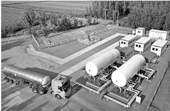
▲6月15日,胜利油田牛页一区试验井组施工现场。该井组设计20口井,将于明年投产。 朱克民 摄 ▼9月2日,在百万吨级CCUS示范区13号站,二氧化碳运输车正在卸油。 朱克民 摄
