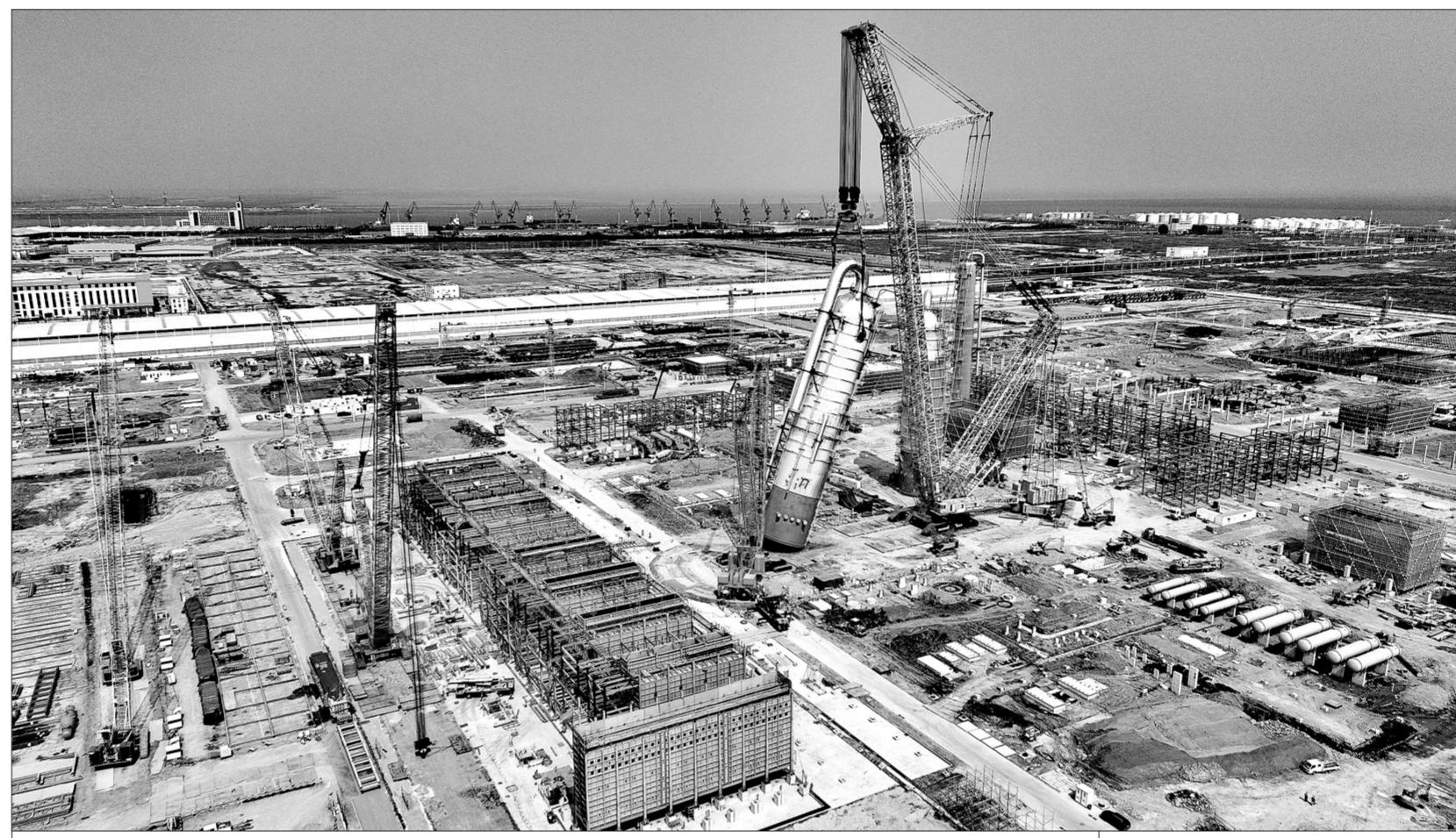
天津南港乙烯项目大型塔器设备全部吊装就位
