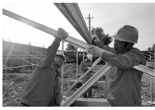
近日,河南油田水电厂开展光伏项目自筹自建工作,预计陆续开工的两个光伏建设项目,9月中旬可全部完工,建成投运后年均发电量为192万千瓦时,平均每年可节约购电费用134万元,减少二氧化碳排放1115吨。图为8月25日,施工人员在安装光伏支架横梁。
