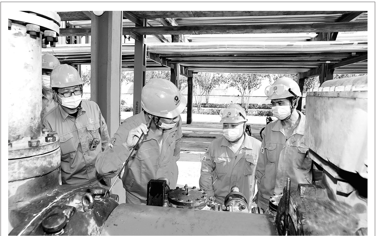
五位一体巡检确保设备安稳运行 沧州炼化持续抓好安全生产工作,在实施24小时不间断巡检的同时,维保单位、运行部人员、操作人员实施“机电仪管操”五位一体巡检,对重点设备集体会诊,制定整改措施,提高日常巡检有效性。图为8月31日,员工检查修复后的机泵状况。 于铁洪 摄
