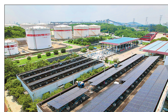
谏壁油库的光伏发电项目年平均发电量42.5万千瓦时,年可节约标准煤233.4吨,减少二氧化碳排放247吨。
