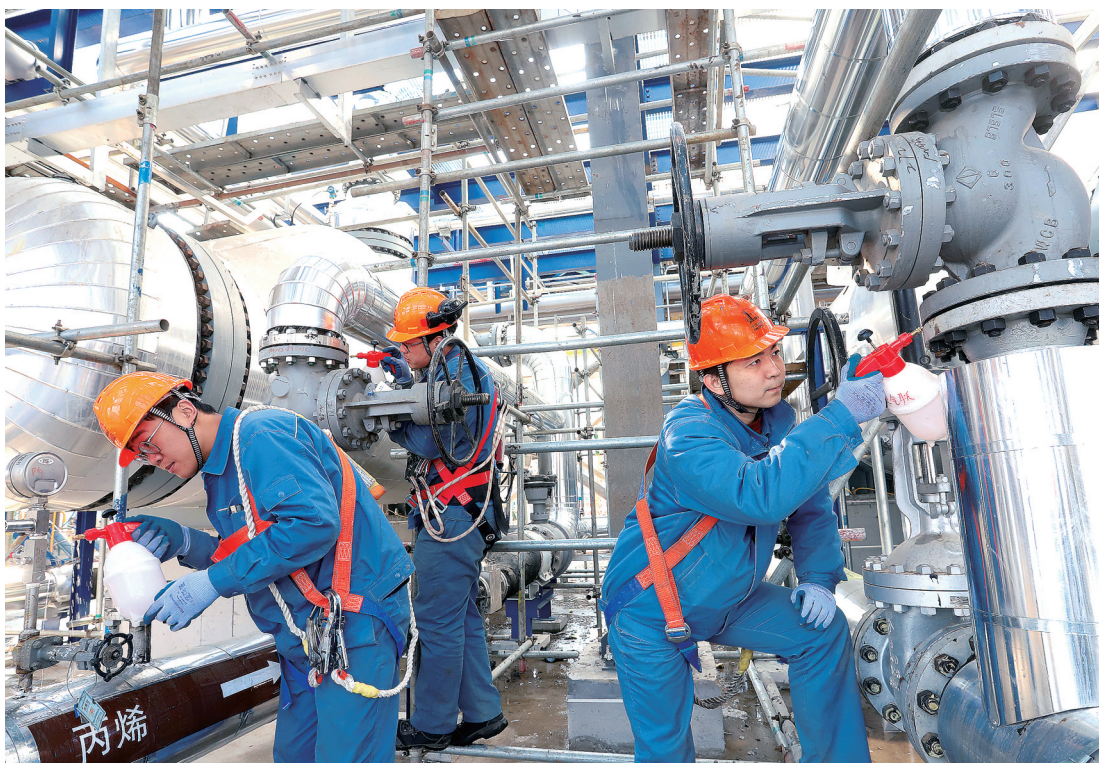
2022年2月25日,齐鲁石化操作人员在CCUS项目现场检查气密。
