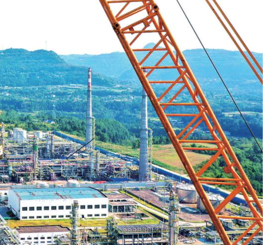
8月17日,西南石油局元坝气田净化厂上空,600吨汽车起重机伸出136米长的吊臂,将2号火炬头平稳地下放到近120米高的平台基座上,标志着中国石化国内上游企业检修中,首次超高空吊装火炬头作业顺利完成。
