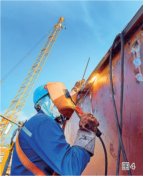
图3为施工人员在钢筋车间进行钢筋加工。图4为PTA项目现场,电焊工正在对仓储系统3万立方米PX储罐壁板进行焊接。
