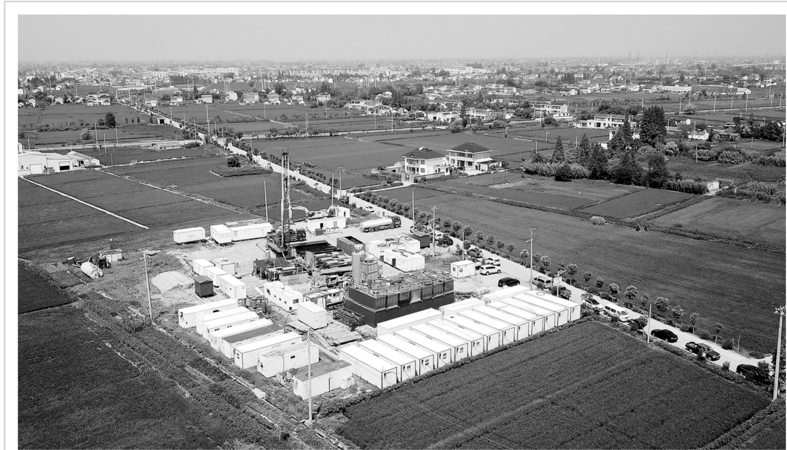
苏北工区首次实施全电动储层改造
