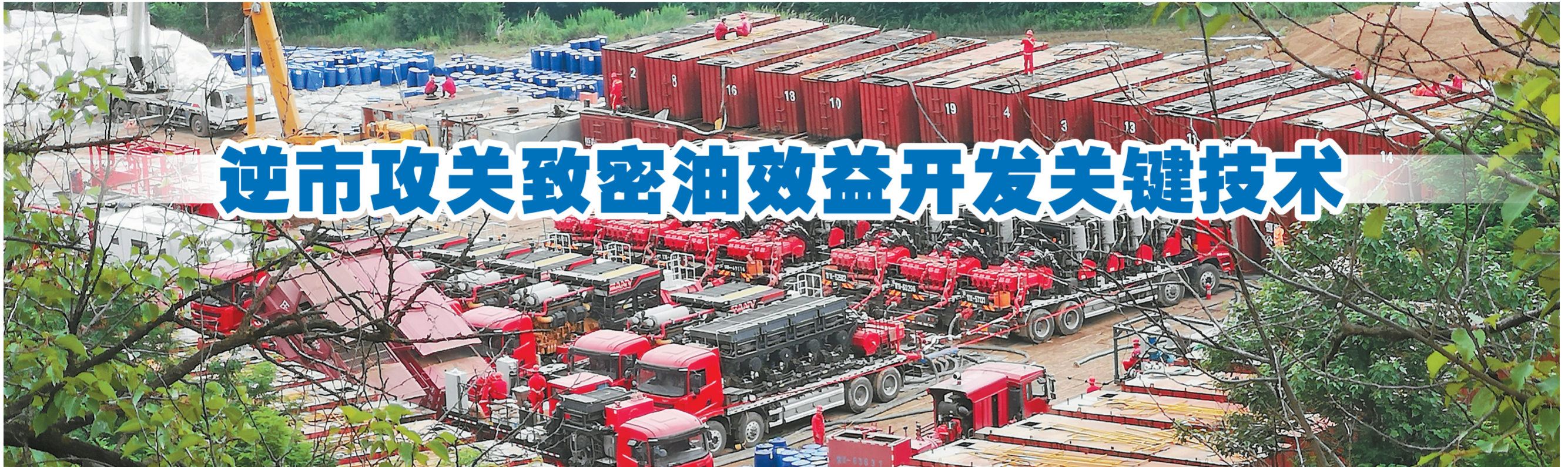
涇河油田JH2P43井大规模压裂施工现场。刘威武 摄
