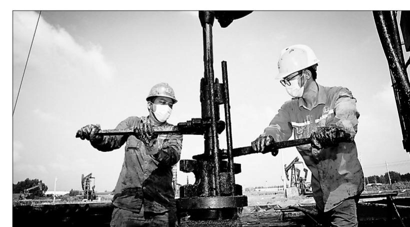
7月,针对持续高温和疫情对油气生产运行带来的不利影响,河南油田干部员工在做好个人防护的同时,通过合理调整施工时间,优化特车使用等措施,科学合理安排施工生产。图为河南油田油服中心员工进行下完井管柱施工。 鲁海涛 摄
