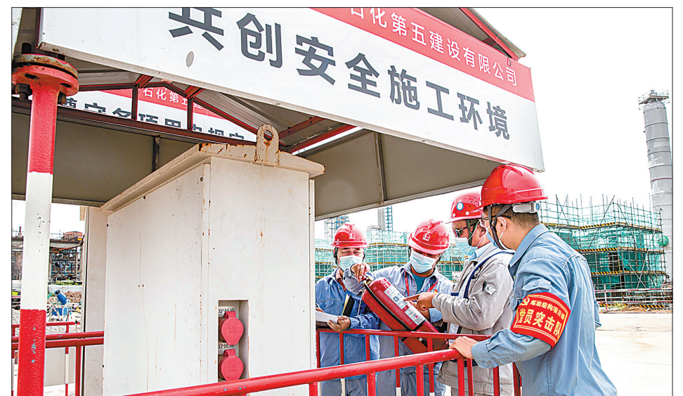
扬子石化炼油结构调整项目成立党员安全督查队,由项目部领导带队,分批分区每日深入施工现场,查找风险隐患,形成问题清单,明确整改要求和时限,形成闭环管理,确保项目安全高效施工。图为7月11日,党员安全督查队在现场检查露天作业临时用电安全。
