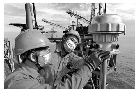
近日,胜利油田海洋采油厂针对雨季开展室外防爆电气隐患排查治理工作,检查电力、工艺、自动化、注采输等系统防爆设备存在的问题,确保海上平台雨季安全生产。图为6月28日,海洋采油厂中心三号平台员工正在检查平台边界灯防爆格兰密封情况。
