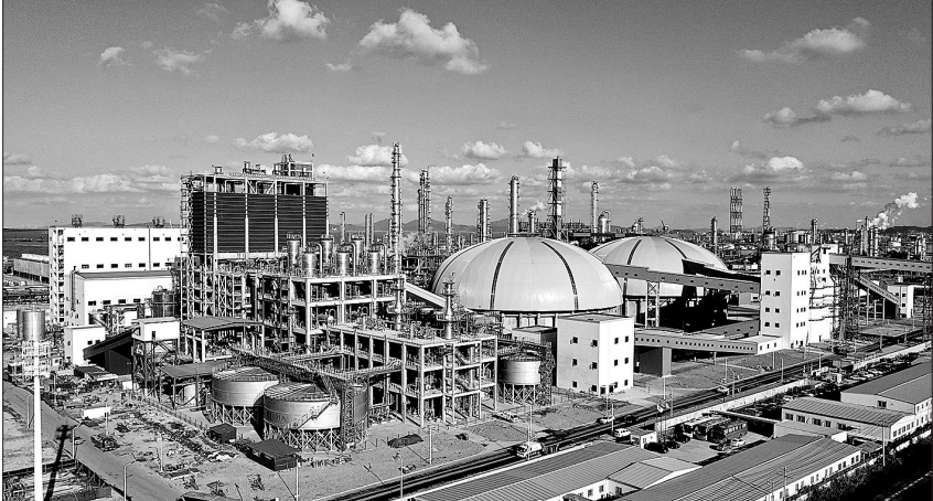
镇海基地煤制氢装置以石油焦和煤为原料,所产纯度为99.9%的氢气,供全厂各加氢用户,同时生产燃料气供动力中心用作锅炉燃料,实现资源充分利用。 张见明 摄
