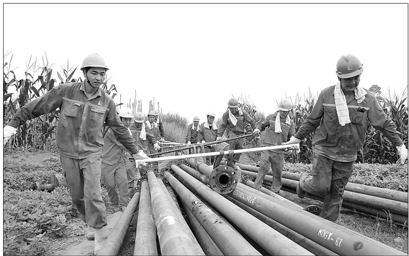
连日来,华北石油工程公司70137HB钻井队克服高温天气施工困难,落实防暑降温保障措施,完成重庆页岩气206H1-1井施工任务,并对钻井设施和放喷管线拆卸回收。图为员工拆卸回收管线。 张均摄
