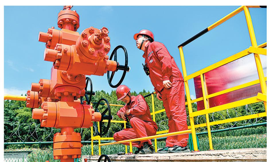
近日,西南石油局江气田采气三厂联合中泽公司开展季度井控应急演练,提升应急处置能力、积累异常事件处理经验。本次演练模拟井口阀门上法兰处刺漏抢险场景,参与演练人员依照方案有序分工配合,采取应急处置措施更换阀门。图为抢险人员现场观察刺漏点,制定下步更换方案。
