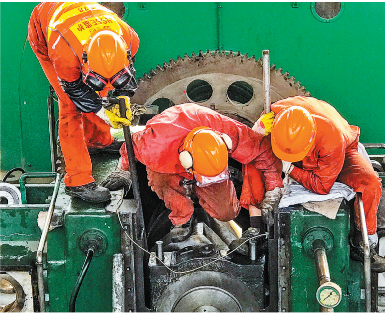
洛阳石化员工对制氢装置压缩机进行检修。
