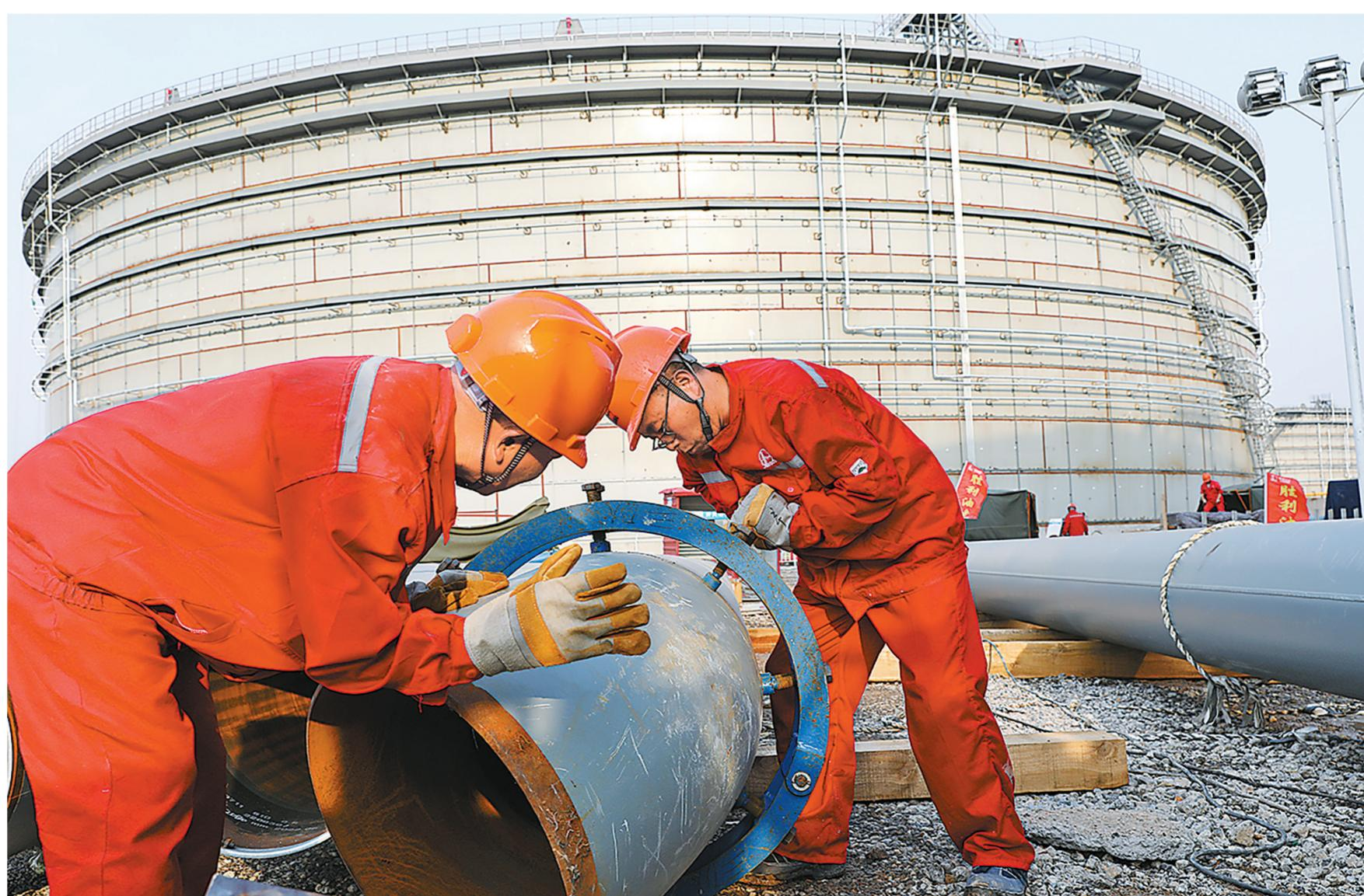
东营原油库迁建项目严把HSE关键节点、重点作业环节管控关,确保施工质量。图为施工人员相互配合,安装管线对口器,做好焊接前的准备工作。
