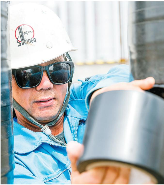
扬子石化炼油结构调整重点项目开展“安全、质量、进度”专项劳动竞赛,全面排查隐患,严格过程控制,确保施工质量。图为施工人员在缠绕管线防腐胶带。
