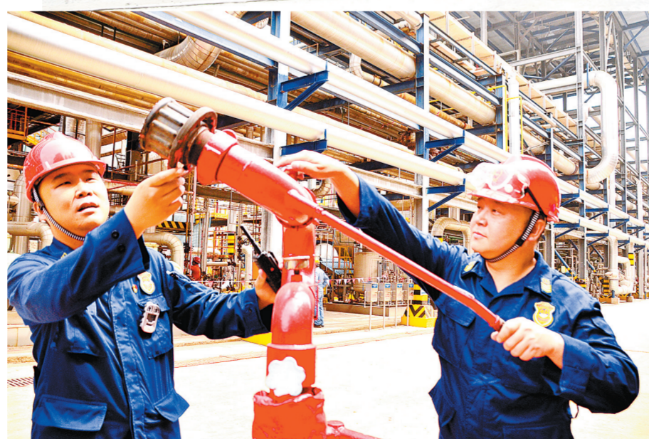
面对近日的持续高温，金陵石化消防保卫支队在做好战备执勤的同时，积极开展装置内消防设施安全检查工作。曾敏摄
