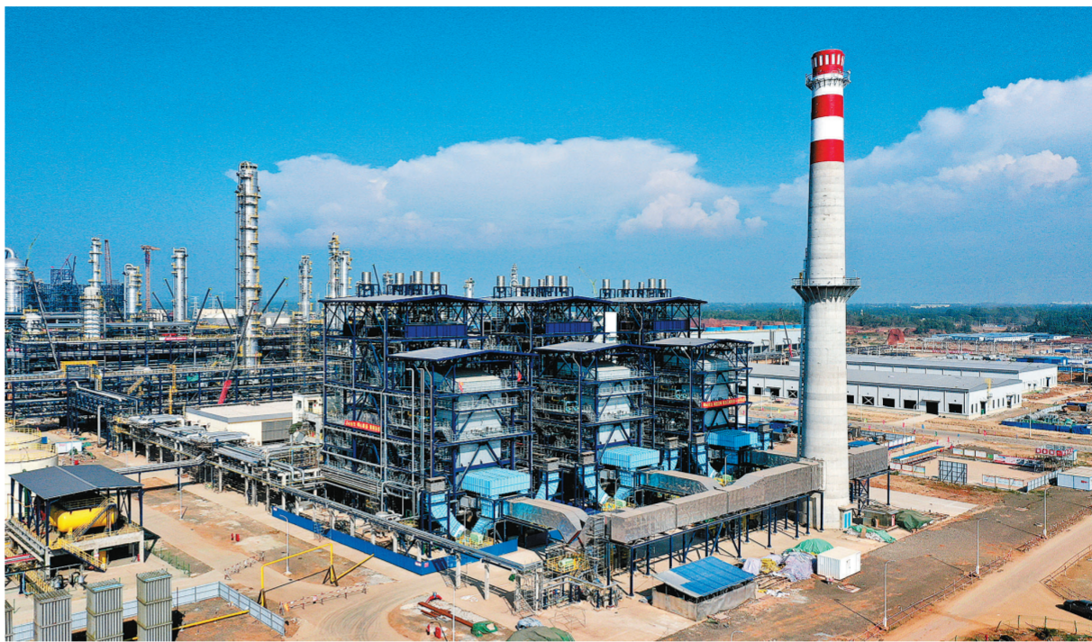
海南乙烯项目动力中心装置全景。
