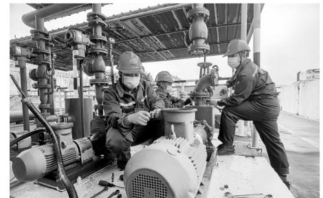
近日,广西钦州石油通过精准计算、调整工艺、合理利旧,对原有海上发油工艺进行改造,解决了发油速度慢、风险系数大等问题,发油速度提高50%以上,大大缩短了装卸时间,提升了客户满意度。图为技术人员对倒油泵设备进行改造。
