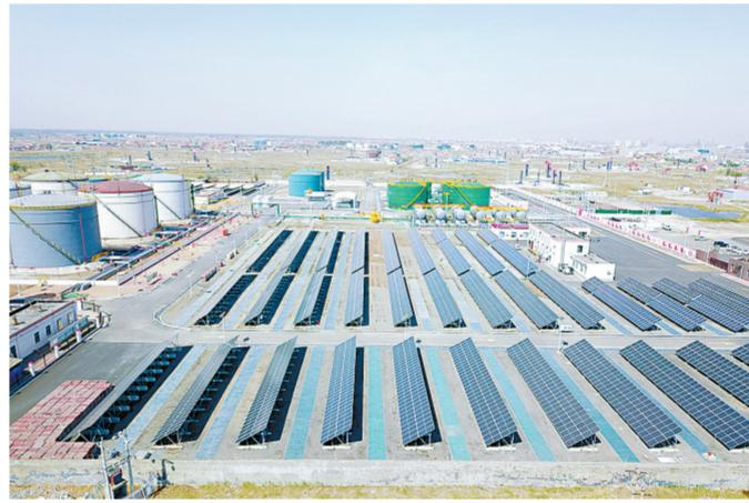
▲采用热力代油,实现加热炉废气零排放;利用集成加药装置,实现包装物零产生;建成光伏发电项目,实现泵站碳中和。胜利油田坨二联合站展现了绿色低碳胜利担当。
