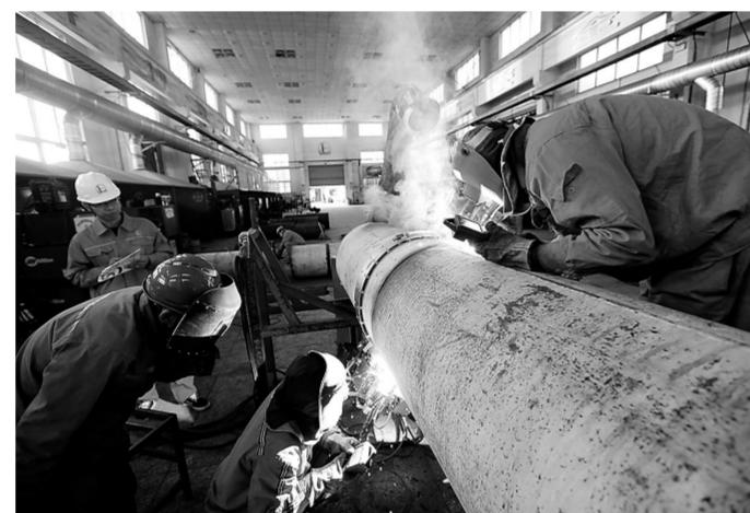
图为石油工程建设公司组织技能大师开展全自动焊接内外焊技术攻关。
