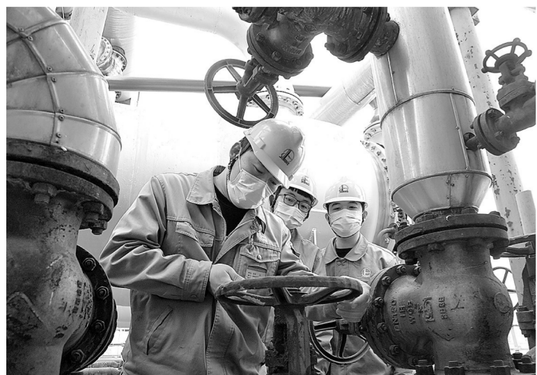
石家庄炼化利用一催化装置余热资源,实施罐区维温热媒水扩径改造项目,节能效果显著。该项目投入运行三个月以来,热媒水量由110吨/时增加至270吨/时,预计年创效400万元。图为3月19日,员工在调整装置参数。 姜军林 摄 王叶敏 文
